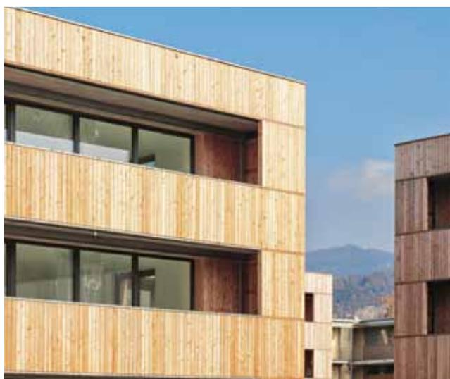
tragenden Stahlstützen, Außenwände aus vorgefertigten, eingeschossigen Holzelementen), das 2011 mit dem Holzbaupreis des Vereins »Vorarlberger Holz-Kunst« ausgezeichnet wurde.
