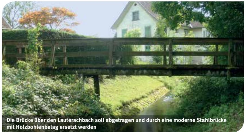
Die Brücke über den Lauterbach soll abgetragen und durch eine moderne Stahlbrücke mit Holzbohlenbelag ersetzt werden
