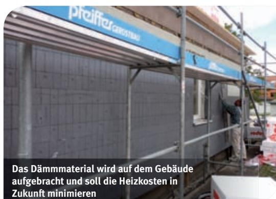
Das Dämmmaterial wird auf dem Gebäude aufgebracht und soll die Heizkosten in Zukunft minimieren
