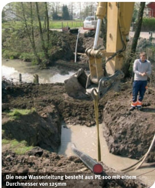
Die neue Wasserleitung besteht aus PE 100 mit einem Durchmesser von 125mm
