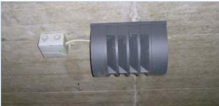
Auf Grund **zahlreicher mutwilliger Zerstörungen der Beleuchtung in der Unterführung** bei der BayWa wurden von der Marktgemeinde Lauterach besser geschützte Lampen montiert. Somit soll sichergestellt werden, dass das leichtfertige Zerstören dieser Lampen erschwert wird. Die Erneuerung der zerstörten Lampen ist mit beträchtlichen Kosten und erheblichem Arbeitsaufwand für die Gemeinde verbunden.
