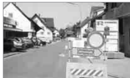
Erneuerung der Kanalisation Lerchenauerstraße
