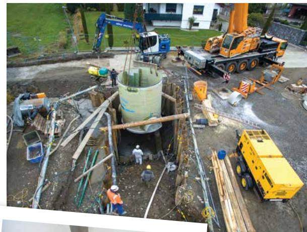
Oben: Ein Blick von oben in den Pumpenschacht des neuen Abwasserpumpwerks
