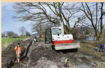
Die Bauarbeiten für die Verlegung von Kanal-, Strom- und Wasserleitungen waren Mitte März noch im vollen Gange
