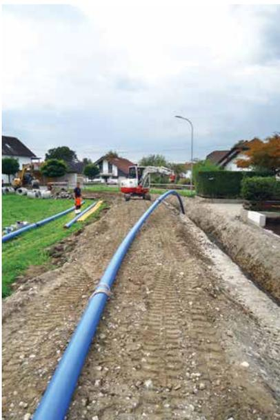
Links: Aufgrund der Straßensanierung in der Austraße wurde die alte Hauptwasserleitung ausgetauscht und zur Netzverstärkung im Industriegebiet vergrößert
