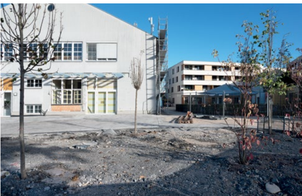
Bauarbeiten auf dem Vorplatz, wo Anfang Oktober neue Bäume gepflanzt wurden.
