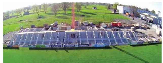
Der Bau der Zuschauertribüne: Die Unterbau-Betonteile für die Zuschauertribüne stehen
