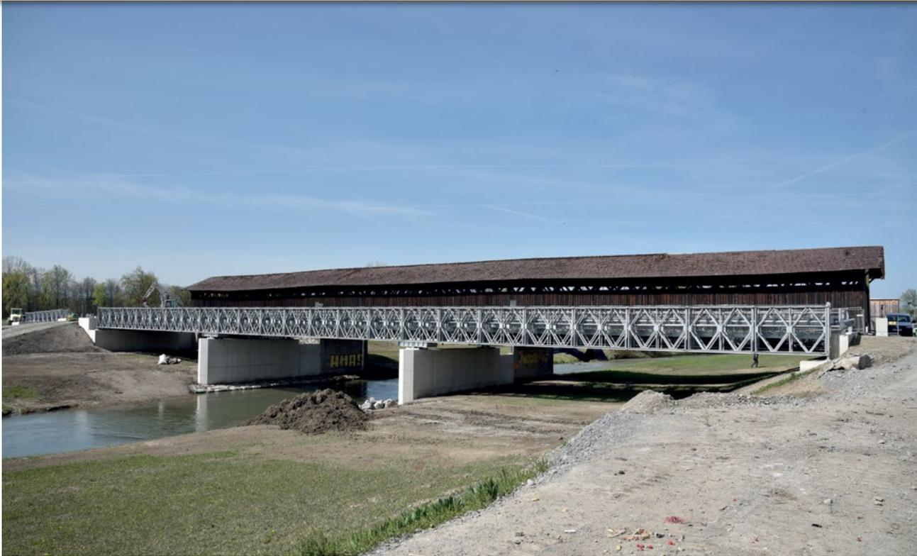
Mit einer Spannweite von über 80 Metern ist die neue Behelfsbrücke mit Kraftfahrzeugen bis 3,5 Tonnen befahrbar
